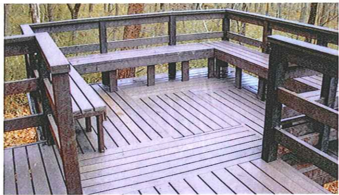
施工完了②
