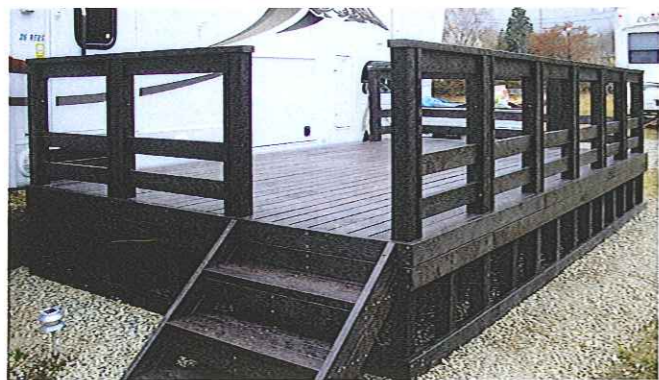
施工完了①
